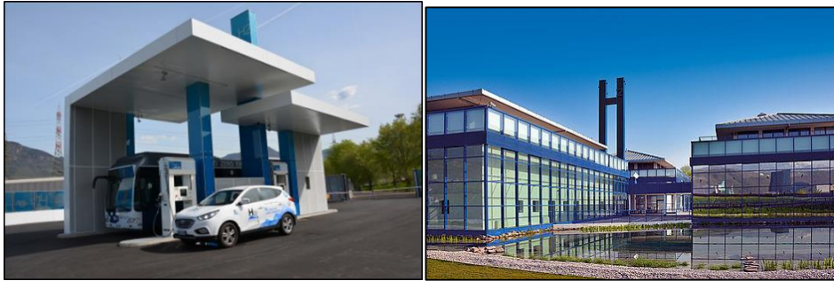
Figura 19: La stazione idrogeno di Bolzano
